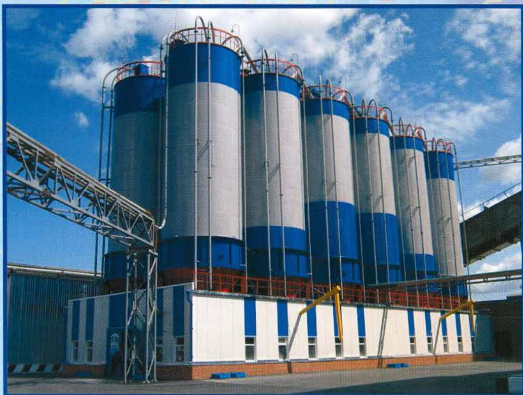
Склад цемента емкостью 6000 тн с подсилосной галереей и приемным устройством
