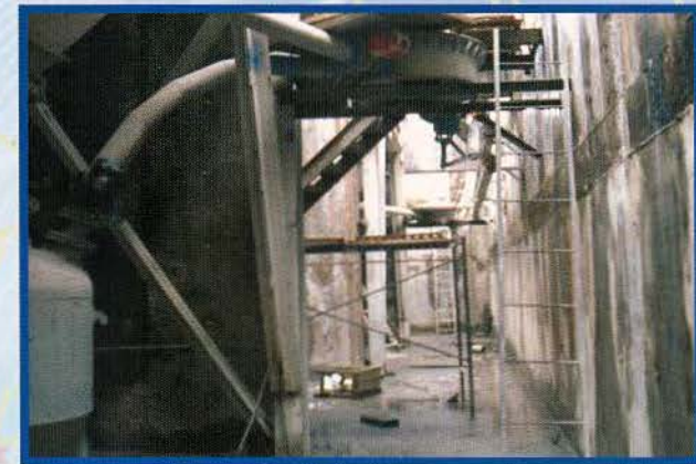
Монтаж коллектора с затворами на цементопроводе подачи цемента
