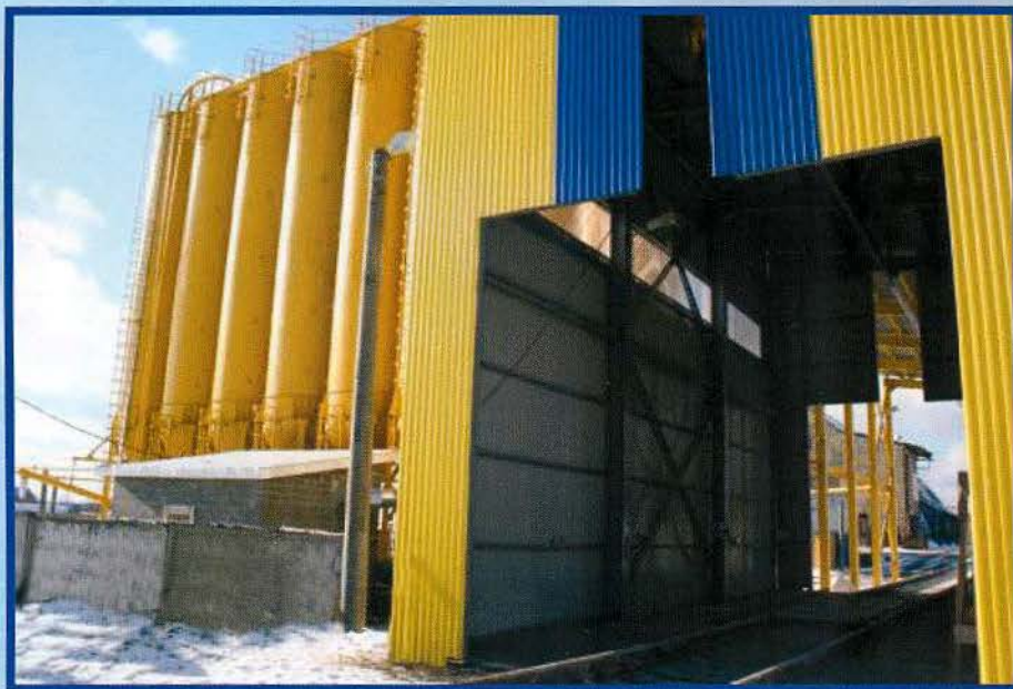
Павильон приемного устройства (вид снаружи)
