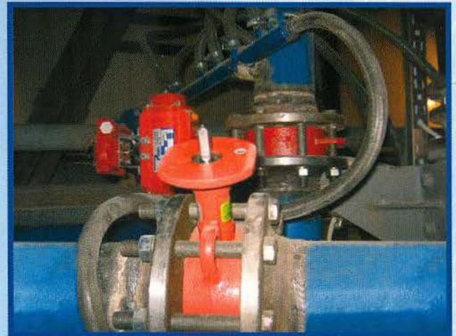
Установка задвижек с пневмоприводом на цементопроводах
