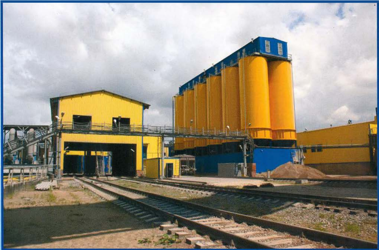
Прирельсовый склад цемента емкостью 6000 тн
