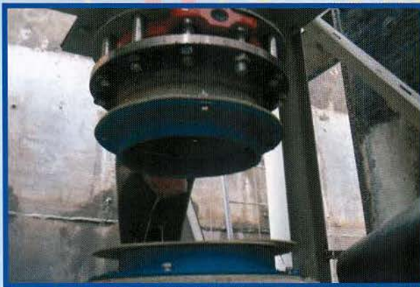
Сборка канала подачи от ножевого затвора под силосом через пневмозатвор к насосу
