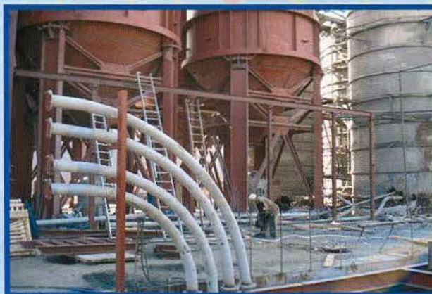
Монтаж каркаса подсилосной галереи
