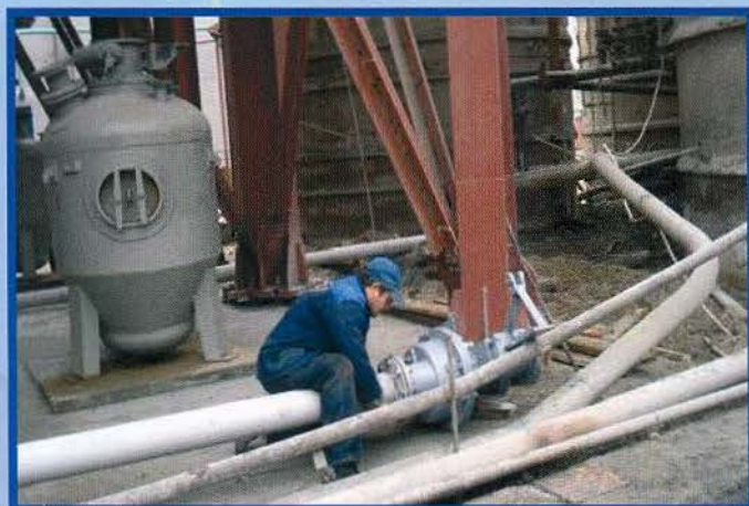
Монтаж двухходового переключателя с электропневматическим приводом на фланцы цементопровода
