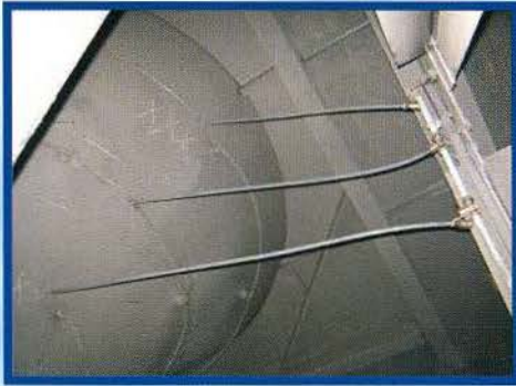
Система аэрирования цемента в конусной части силоса
