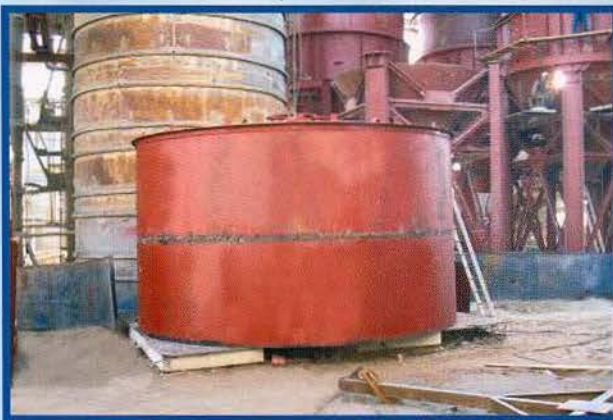
Сборка обечайек и подготовка к покраске
