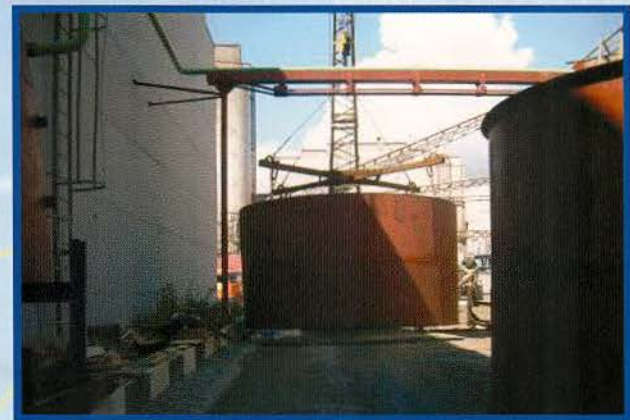
Установка обечайек на нижний венец силоса (толщина 18мм)
