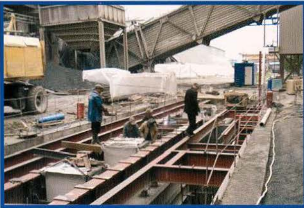
Монтаж конструкций приемных устройств цемента из железнодорожных вагонов
