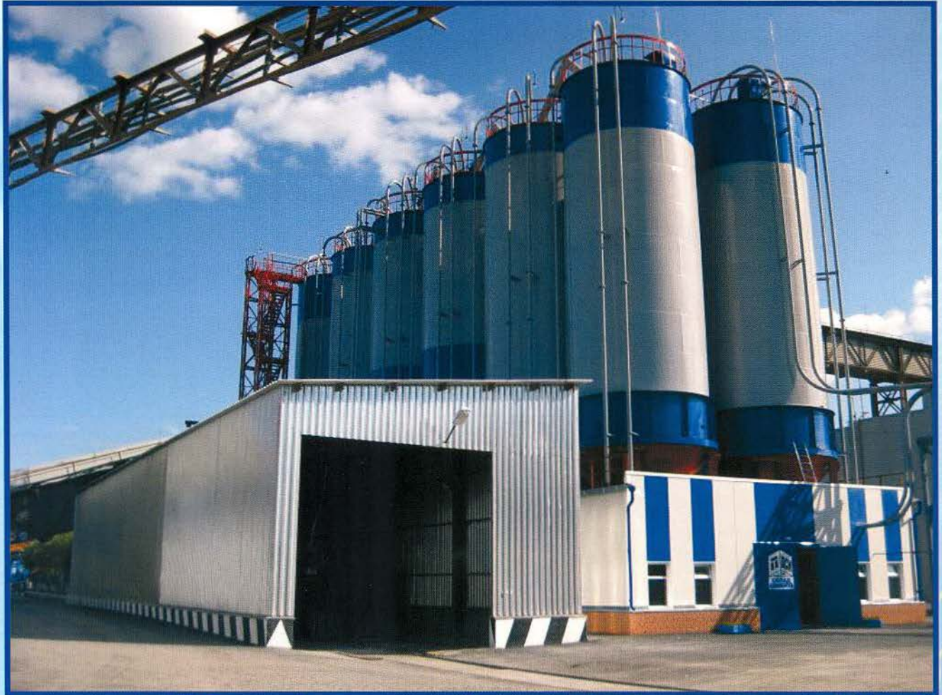
Склад цемента емкостью 6000 тн с подсилосной галереей и приемным устройством
