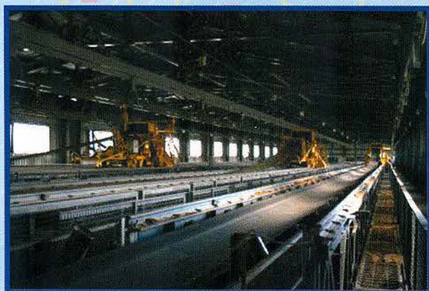
Надбункерное помещение склада заполнителей с разгрузочными тележками
