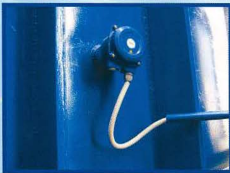
Система аэрирования цемента в конусной части силоса
